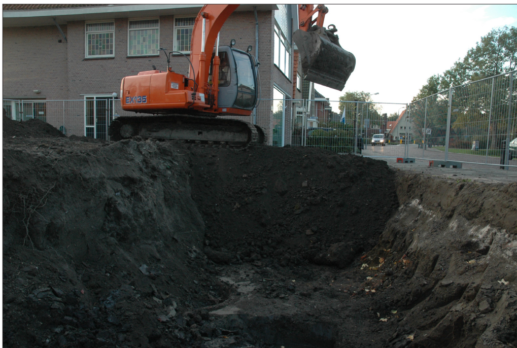
Afbeelding 2. De rupskraan moest diepe gaten graven en op de stort balanceren. Foto richting zuiden.
